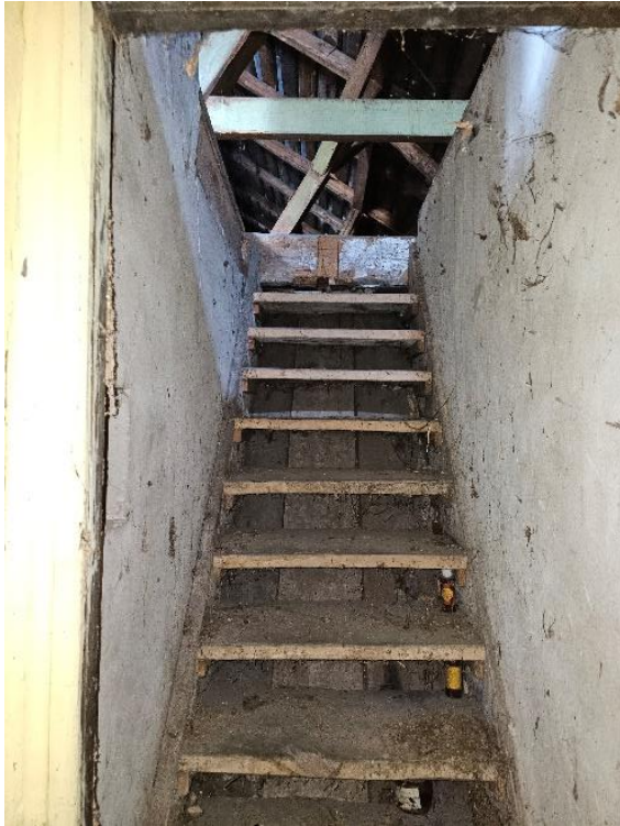
Fotografia 19 Schody prowadzące na poddasze
