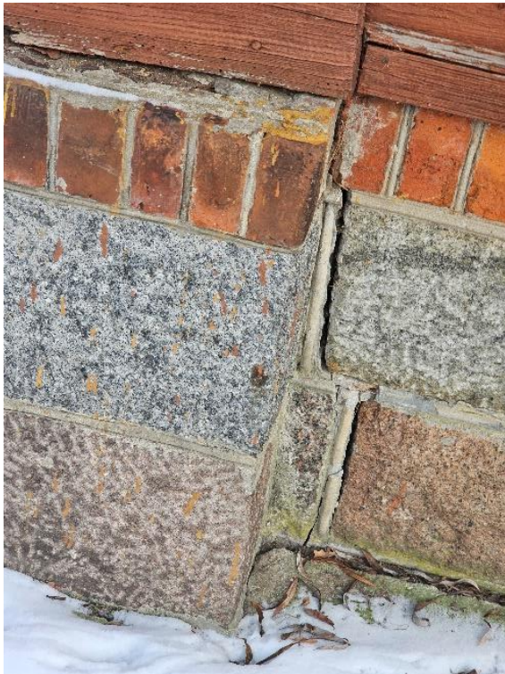
Fotografia 17 Podmurówka budynku plebanii
