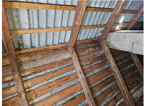
Fotografia 20 Widok krokwi, deskowania i pokrycia z eternitu
