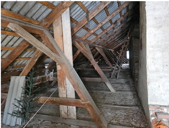
Fotografia 21 Więźba dachowa w przestrzeni poddasza nieużytkowego
