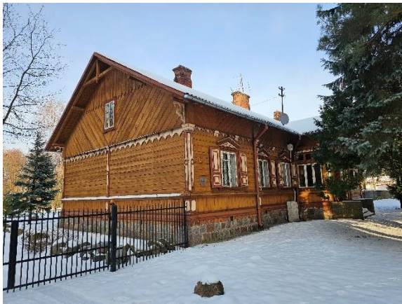
Fotografia 13 Widok elewacji plebanii
