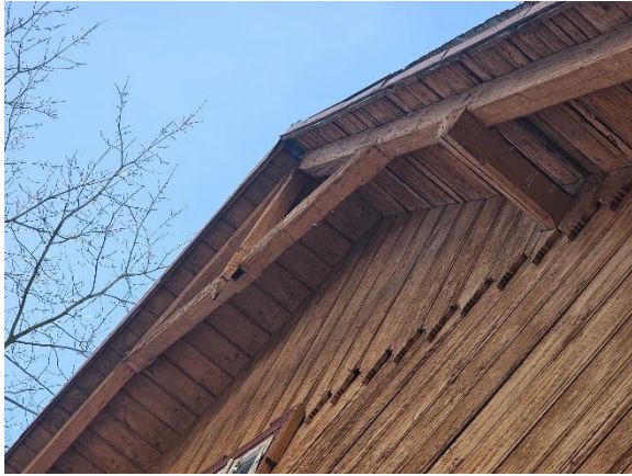
Fotografia 15 Zewnętrzne wykończenie podbitki dachowej i skrajnej krokwi
